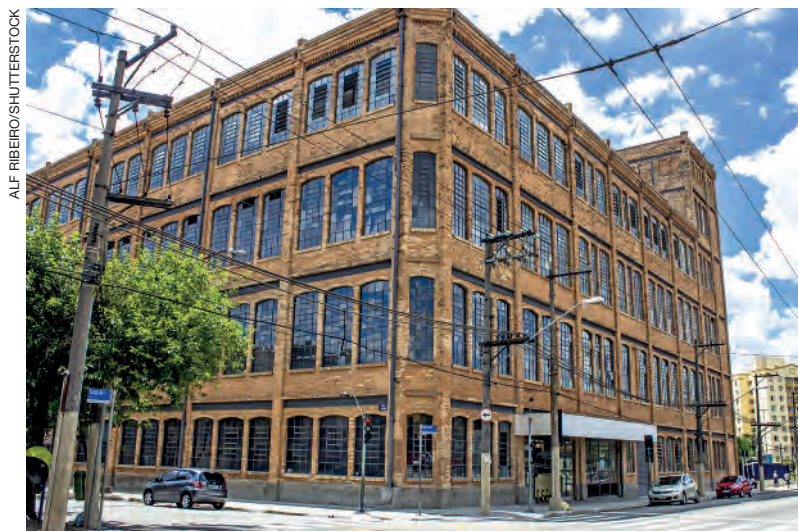
Prédio do antigo Cotonifício Rodolfo Crespi, um dos mais maiores da época, fundado em 1897, no bairro da Mooca, cidade de São Paulo (SP). Foto de 2012.
