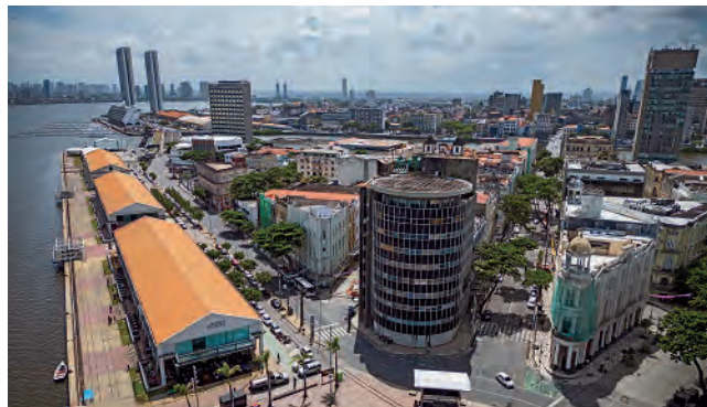
Prédio com formato cilíndrico no centro histórico de Recife (PE). Foto de 2024.
