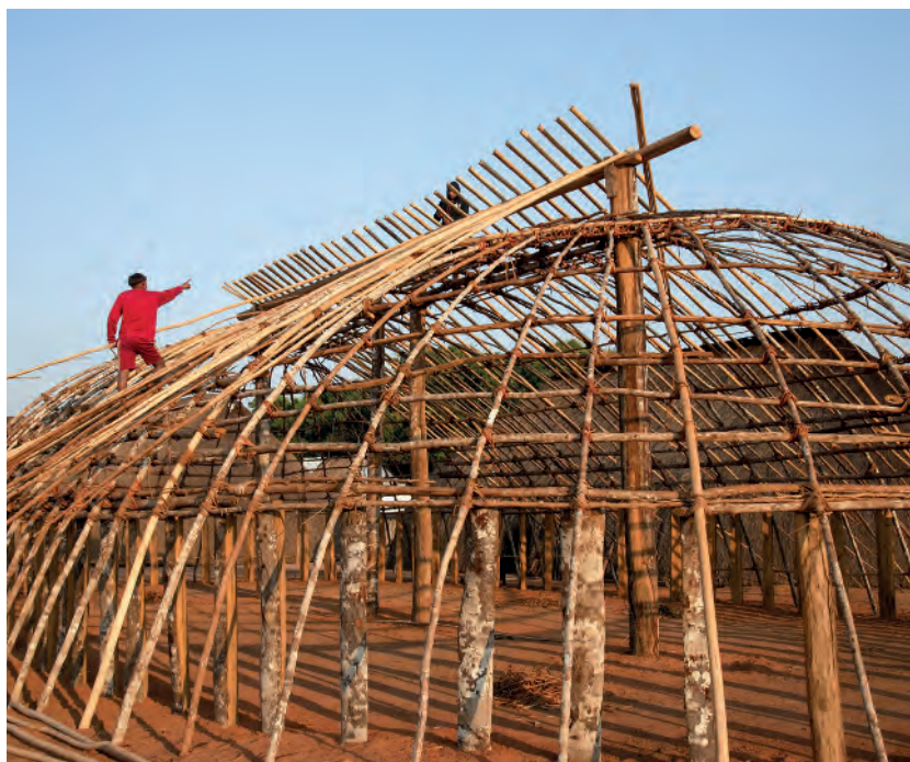
Construção de oca pelo povo Waujá, na Aldeia Piyulaga, no Parque Indígena do Xingu, em Gaúcha do Norte, no Mato Grosso. Fotografia de 2019.
