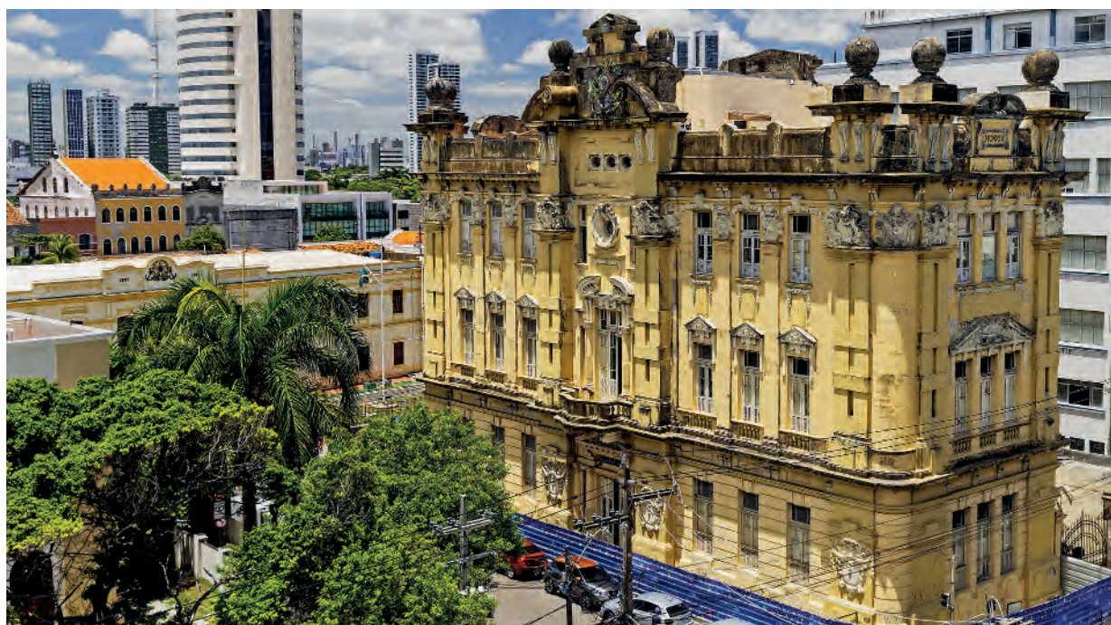
Edifício da Secretaria de Ciência, Tecnologia e Inovação do Estado de Pernambuco, em Recife, Pernambuco. Fotografia de 2024.
